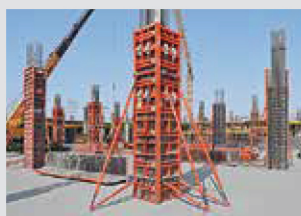
Column Formwork 기둥 거푸집
