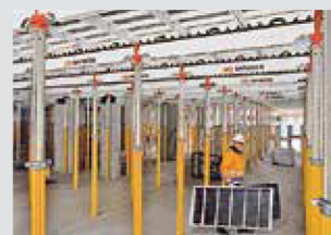
Slab Formwork 슬라브 거푸집
