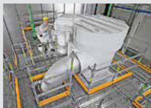
Industrial Scaffold 산업용 비계
