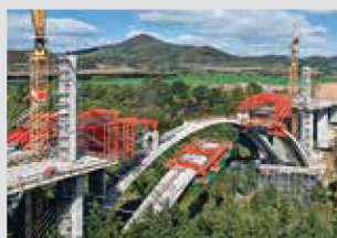
Bridge Formwork 교량 거푸집
