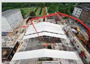
Protection Scaffold 프로텍션 비계
