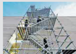
Access 작업 비계
