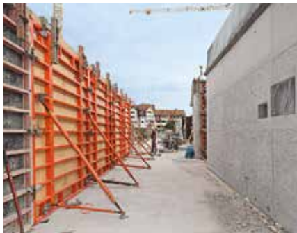
TRIO는 입증된 패널 거푸집 시스템의 변형으로, 다양한 TRIO 부품들과 함께 사용될 수 있습니다.
