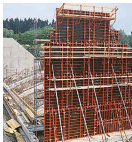
TRIO 330을 통해 높은 벽체를 매우 빠르게 시공할 수 있습니다. 4개의 패널만을 사용하여 13.20 m 높이의 벽체를 구현할 수 있습니다.
