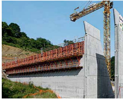
Lurberria Dam, St Pée Sur Nivelles, France
