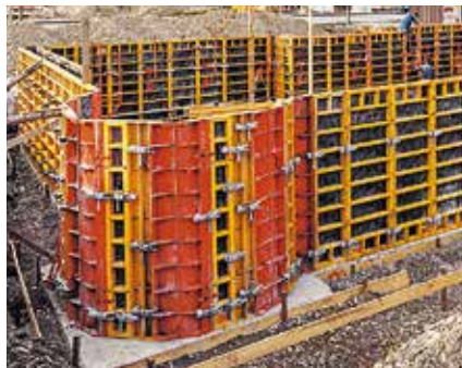
TRIO Alu는 크레인이 없어도 손으로 쉽게 운반이 가능한 경량의 대안책입니다.
