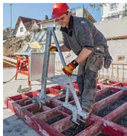
작업 발판은 해당하는 넓이의 부품에 장착되며 임시 보관 시에도 거푸집에 부착되어 있습니다.
