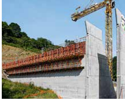
Lurberria Dam, St Pée Sur Nivelles, France
