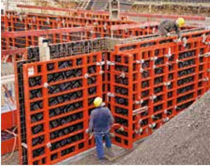
주거용 건물 Neuperlach, Munich, Germany
