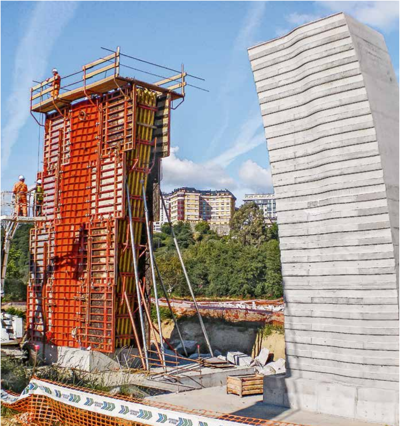
교각에 사용된 TRIO : 추가 나무 문양으로 흥미로운 표면 구조가 됩니다.
