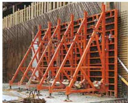
SB-B와 SB-C 브레이스 프레임 유닛으로 TRIO 판넬 거푸집의 콘크리트 타설 높이는 3.50m입니다.
