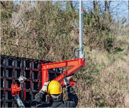
스캐폴딩 브라켓 듀오 70은 판넬 프레임 개방부에 끼워서 설치한다. 페리 안전 난간대는 별도의 고정 장치 없이 브라켓에 바로 설치할 수 있다.
