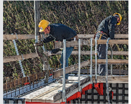
너비 70 cm의 작업용 발판과 반대면 안전난간을 설치하여 타설 작업 시 안전한 작업 환경을 확보할 수 있다.
