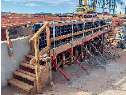
듀오 브래킷과 안전난간 지지대를 보조 목재 구조물과 같이 사용, 안전한 작업공간과 통로를 구축하였다.
