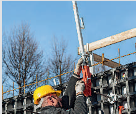
브레이스 커넥터 듀오를 듀오 난간 거치대 (Guardrail Post Holder DUO), 안전 난간대와 조립하여 반대면 안전난간을 설치한다.
