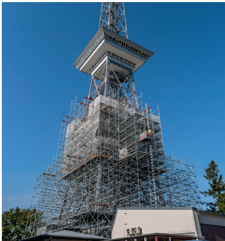
낡은 페인트를 제거하고 새로 부식 방지 처리를 해야 했으며, 철골 구조물은 완전히 다시 칠해야 했습니다.
